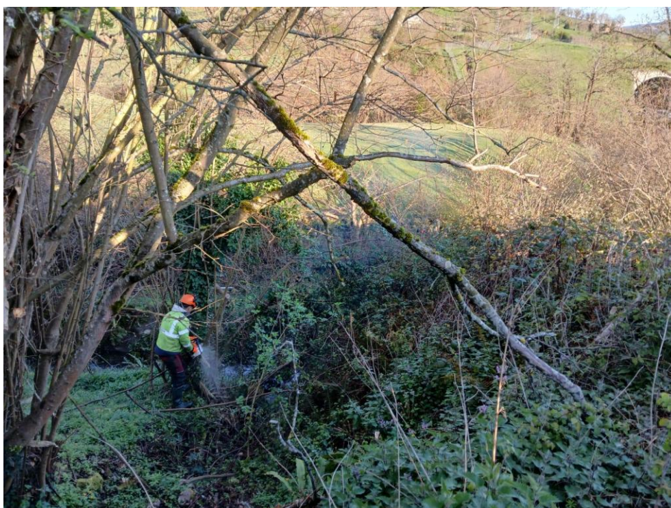
Durante los trabajos
