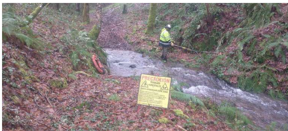
Después de los trabajos
