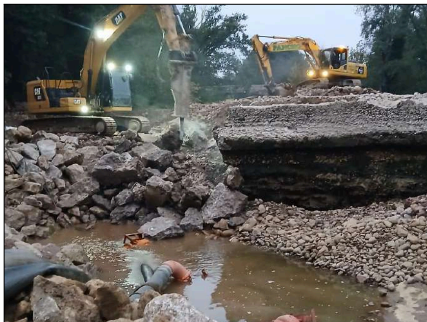
Demolición y retirada del antiguo azud
