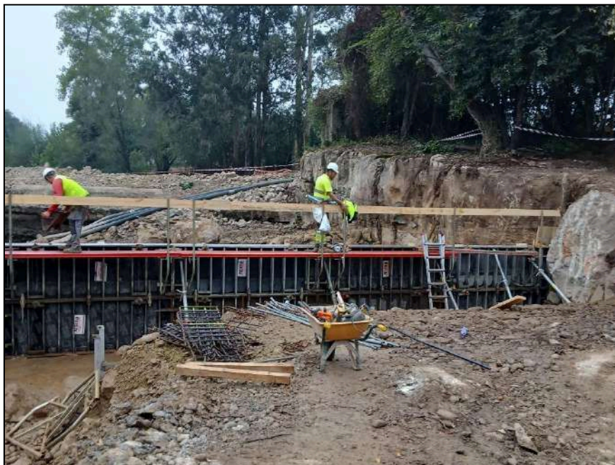
Trabajos de encofrado de la nueva estructura de aforo
