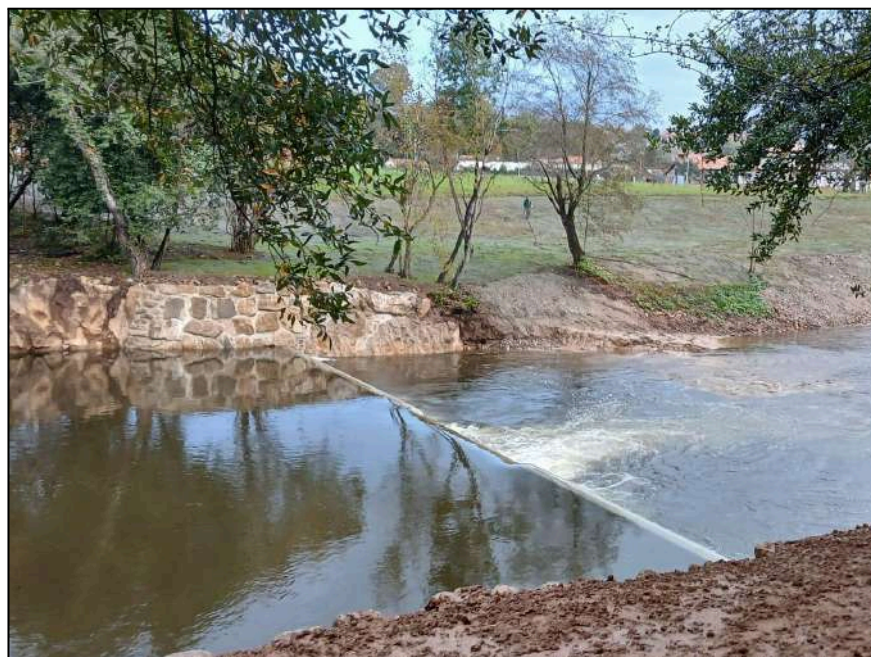
Vista de la nueva estructura de aforos en el río Saja
