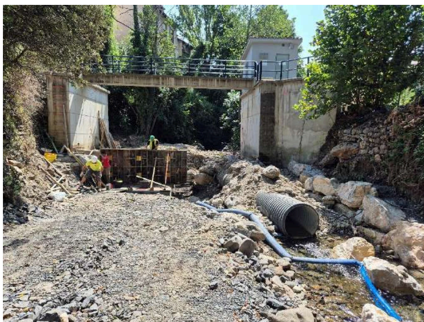
Trabajos de encofrado de la nueva sección de aforo en el río Bullón
