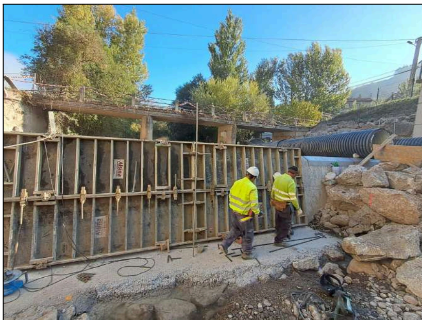
Trabajos de encofrado de la nueva estructura de aforos del río Deva
