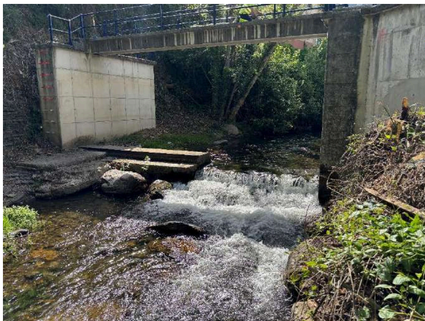
Previo a la actuación, estado de la estructura de medición de caudales de la estación SAI 1264 río Bullón en Ojedo
