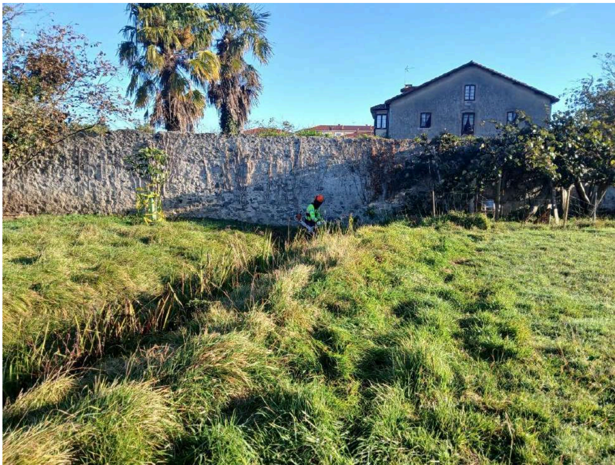
Durante los trabajos
