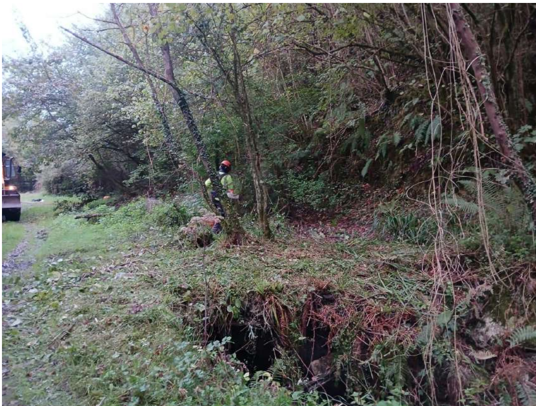
Operarios trabajando en la conservación
