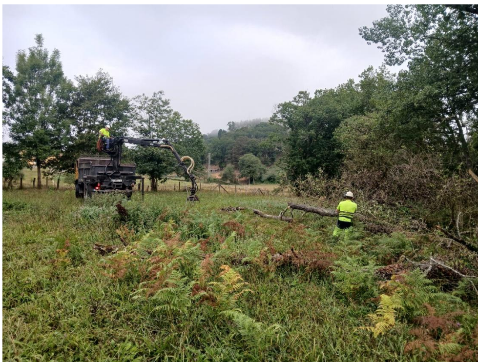
Durante los trabajos
