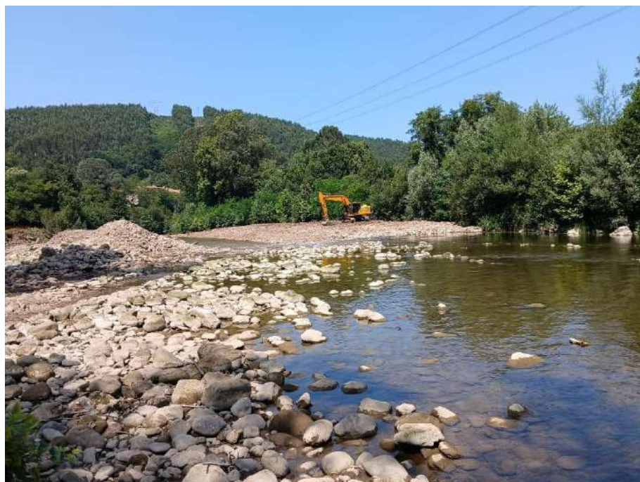
Trabajos de desvío del cauce para posibilitar los trabajos en la infraestructura
