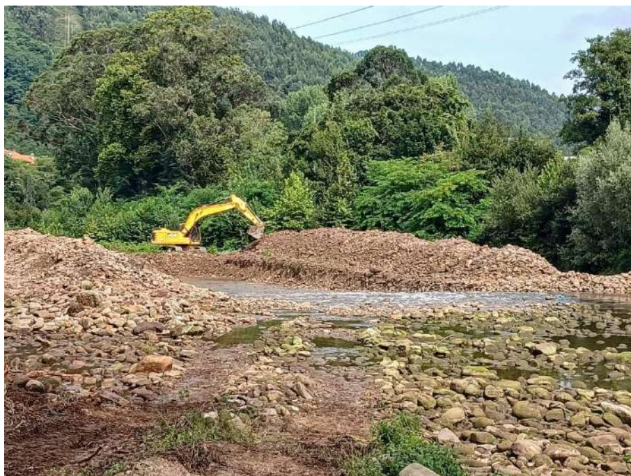
Trabajos de desvío del cauce
