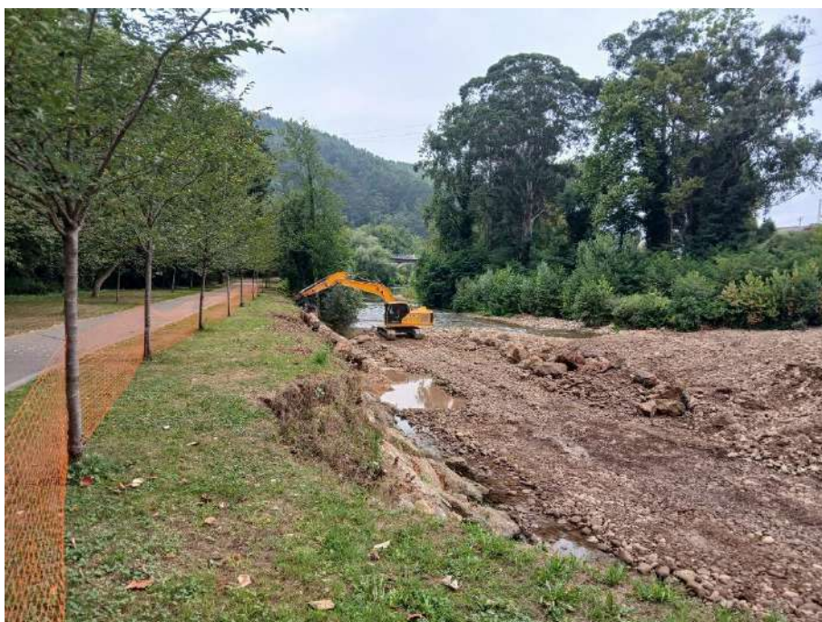
Trabajos de reparación de la escollera
