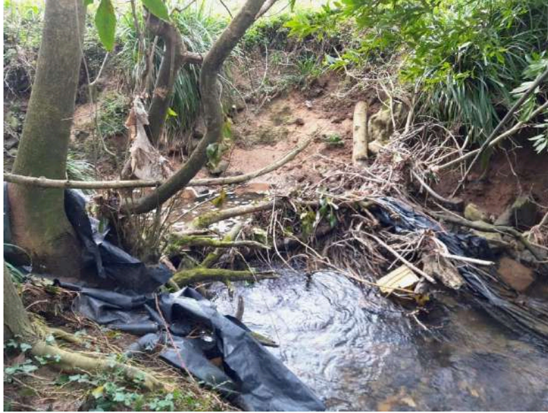
Previo a la actuación, se observan acumulaciones de restos vegetales y restos de origen antrópico
