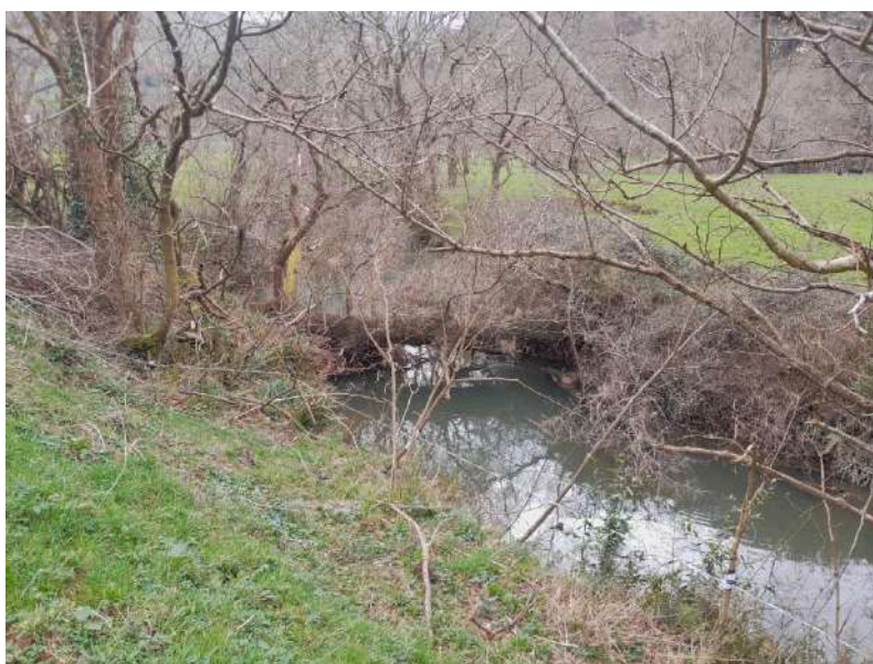
Árbol de grandes dimensiones caído sobre el cauce del río Clarín
