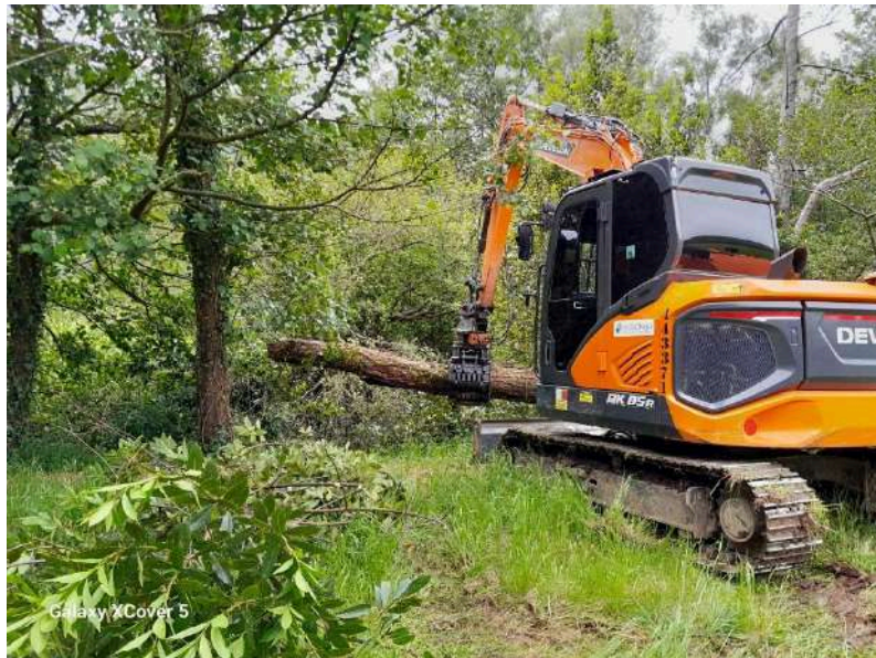
Retirada de arbolado caído con retroexcavadora equipada con pinza
