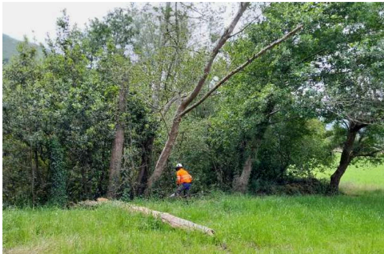
Trabajos con motosierra para la retirada de arbolado con riesgo de caída
