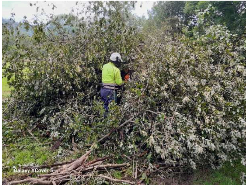
Trabajos de retirada de restos vegetales con motosierra
