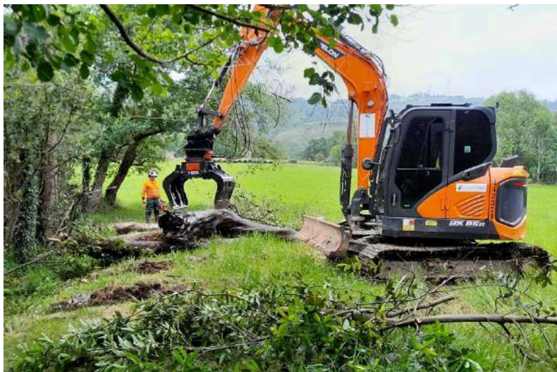
Retirada de restos vegetales acumulados en el cauce del río Clarín
