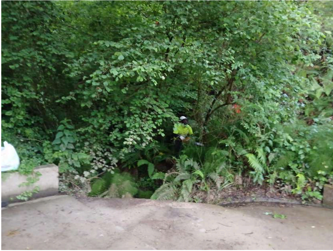
Operarios trabajando en el cauce
