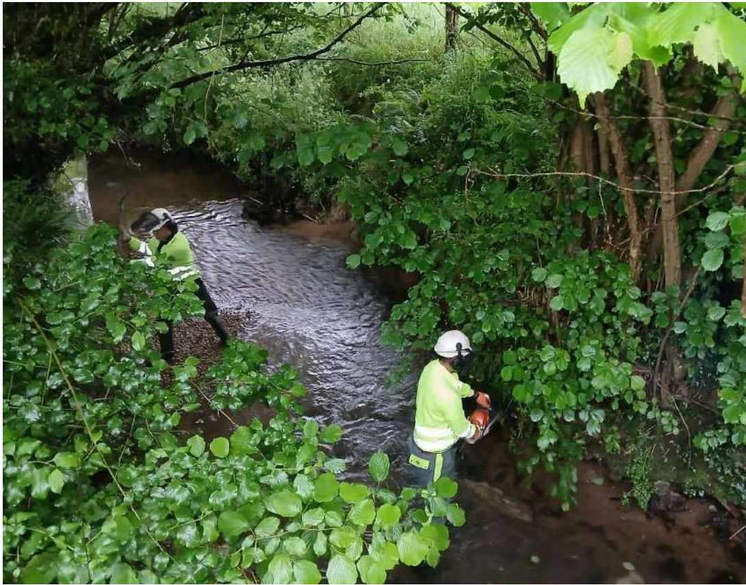
Operarios trabajando en el cauce del río Noreña
