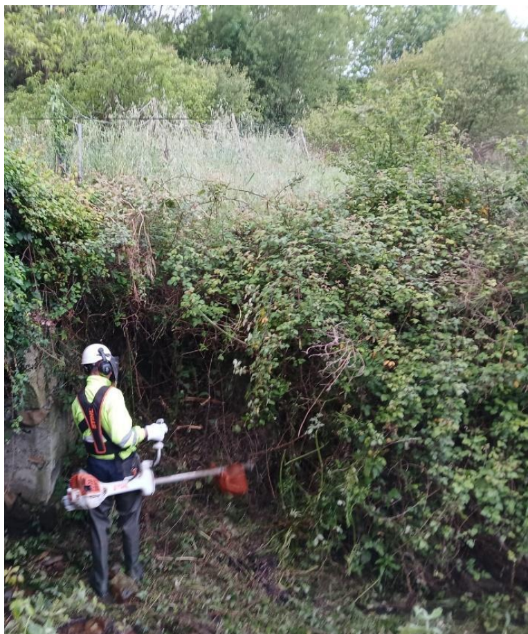
Operario desbrozando dentro del cauce
