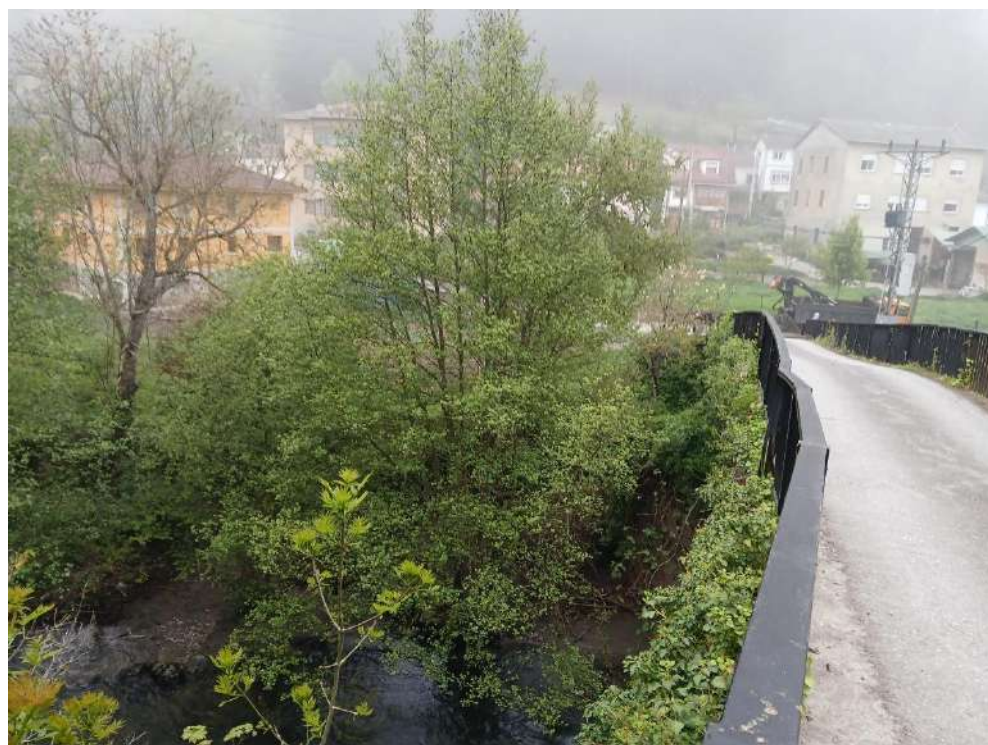
Antes de los trabajos
