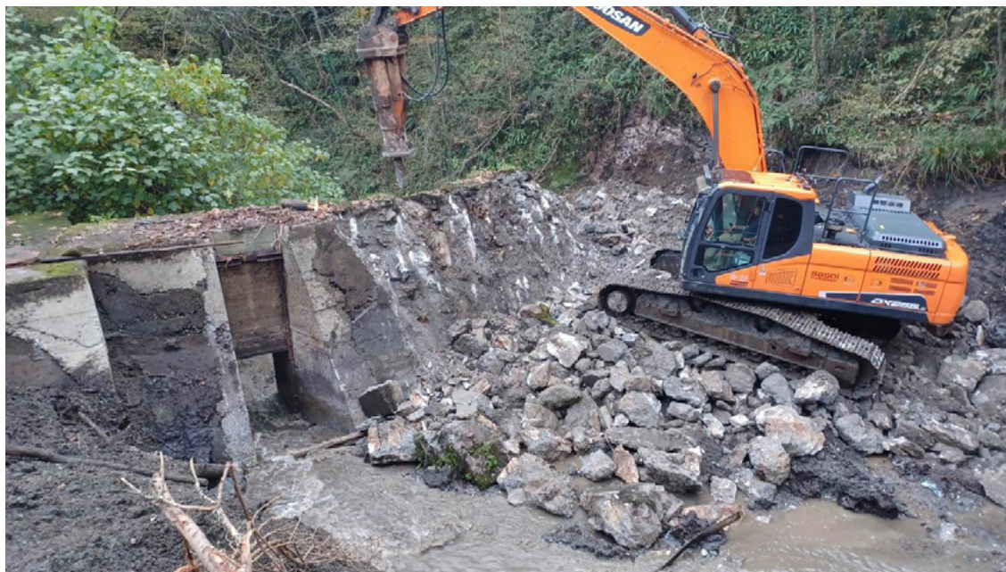
Trabajos de eliminación de presa y azudes en la regata Latsa
