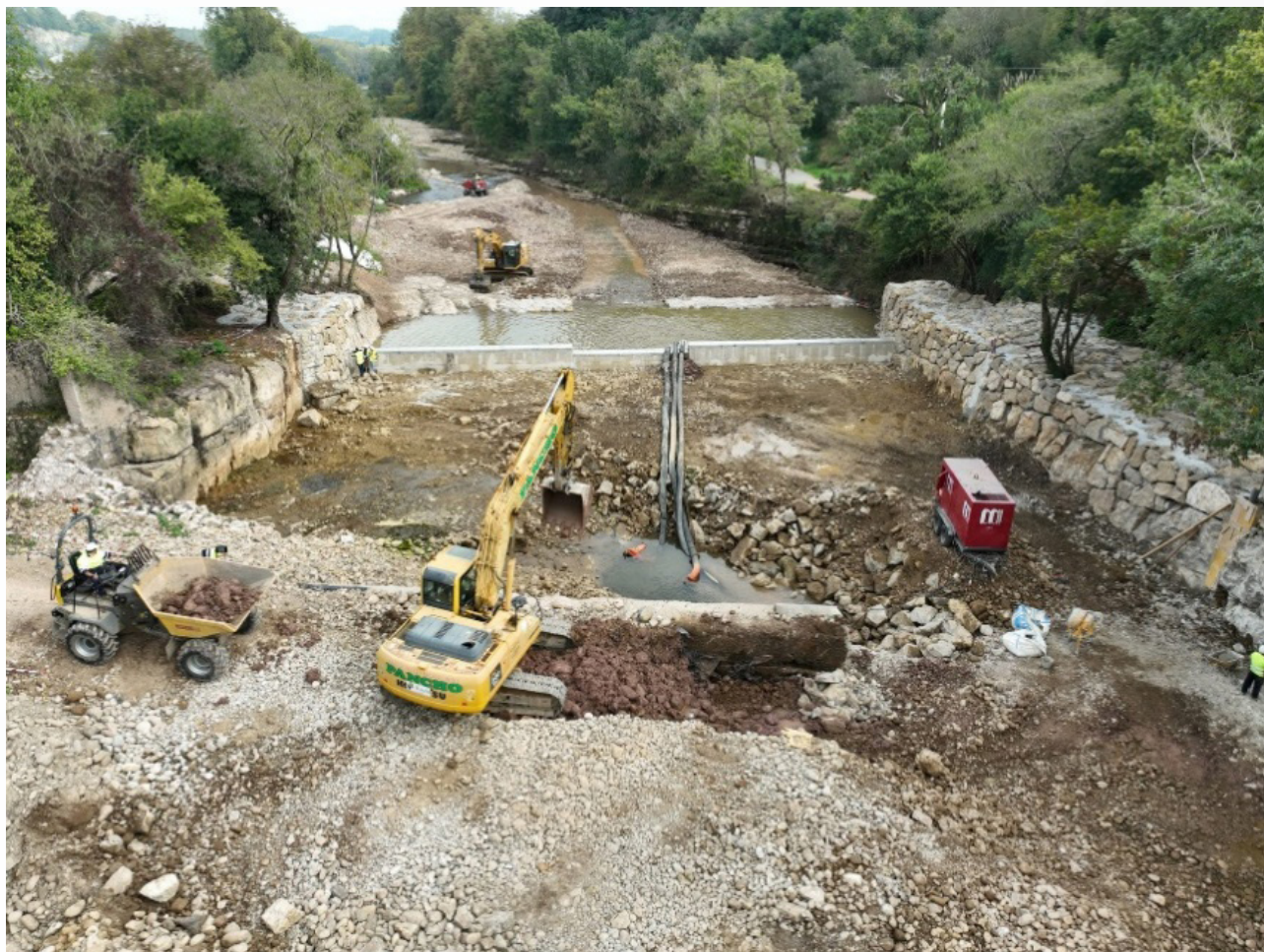
Foto 6: Obras de reconversión en nueva Estación SAI del azud de Pavón en el río Saja (Cantabria).
