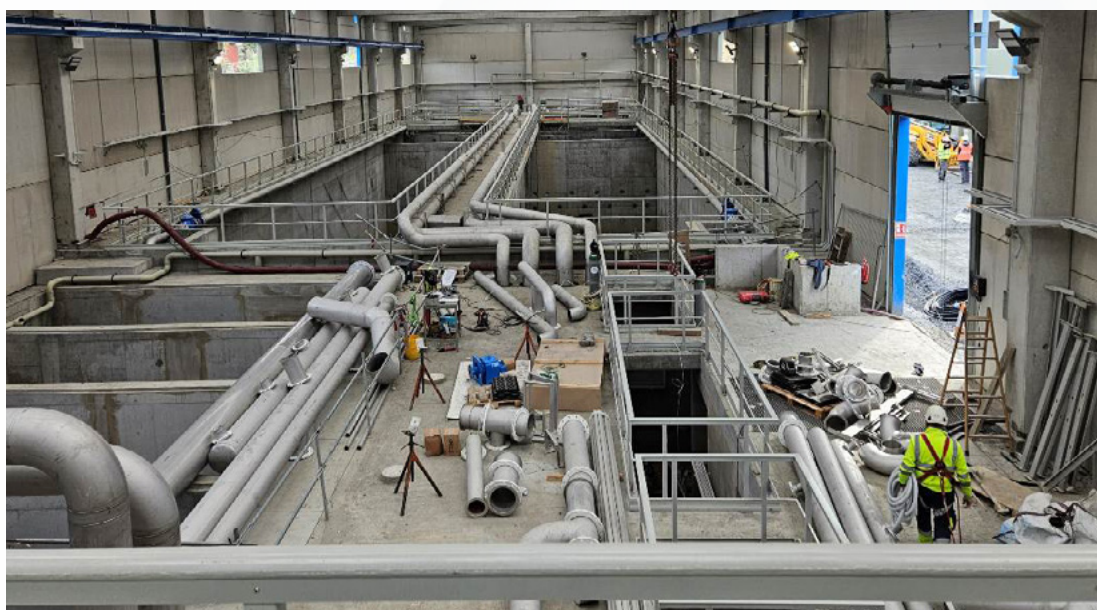
EDAR de Basaurbe. Calderería e instalaciones
