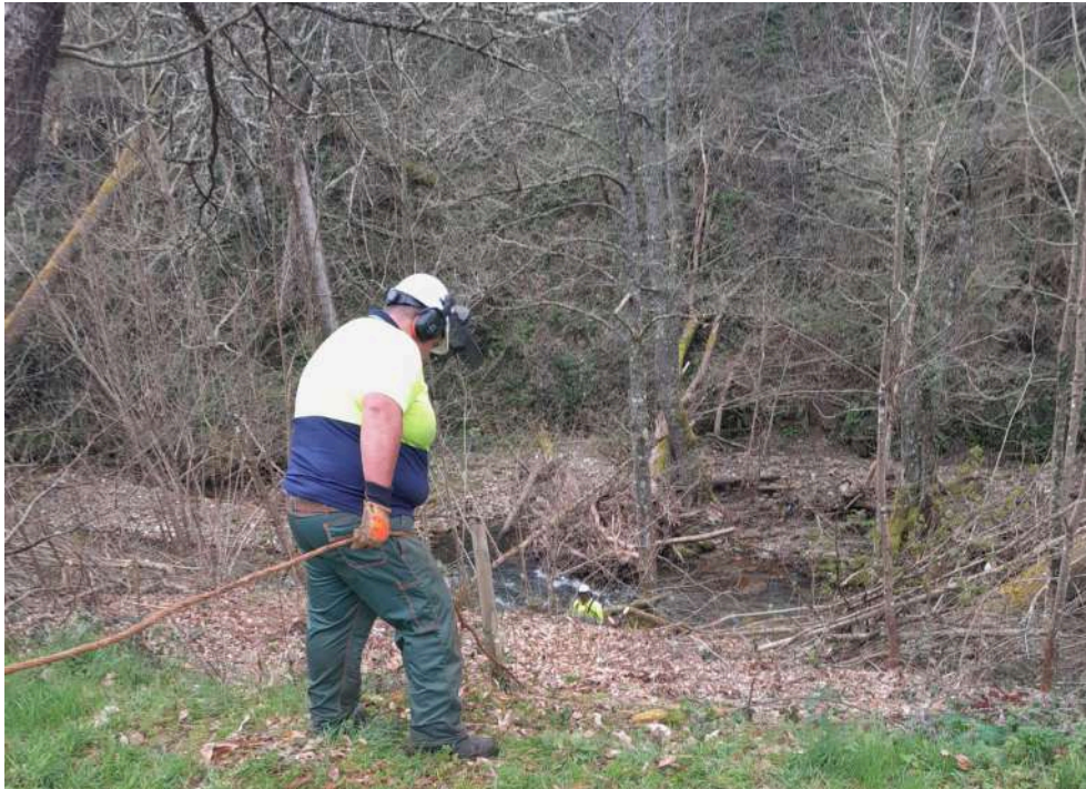
Operarios cableando madera para sacarla del cauce
