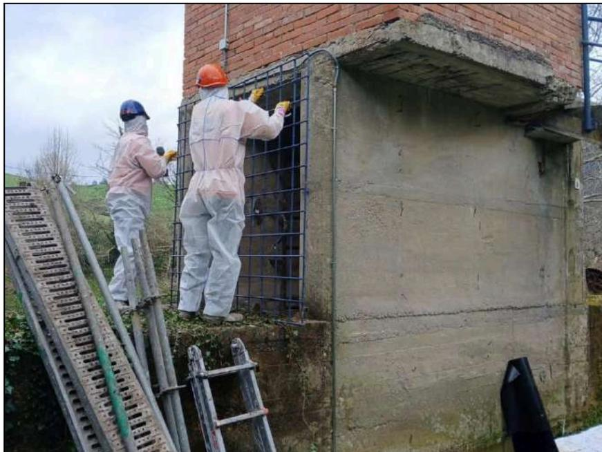
Trabajos de retirada de una tubería de fibrocemento
