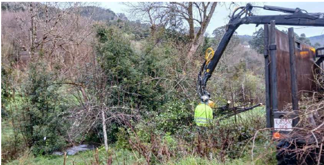
Durante los trabajos. Operarios retirando restos vegetales
