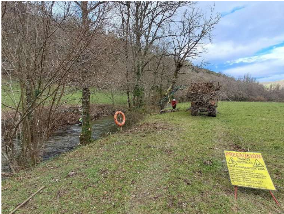
Operarios trabajando en el río
