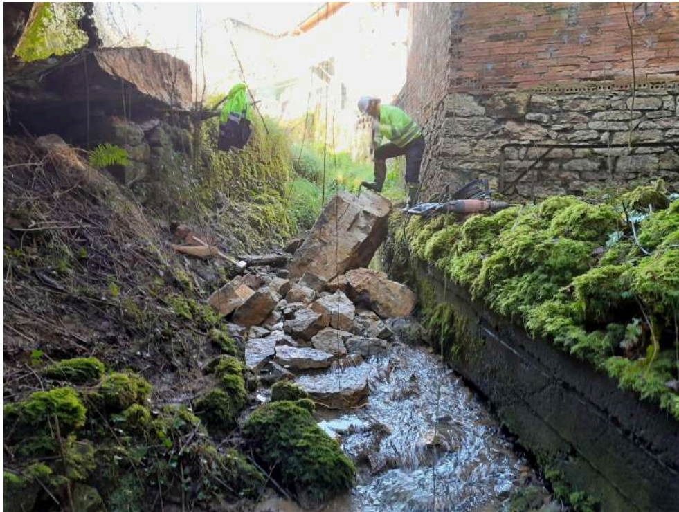
Durante los trabajos
