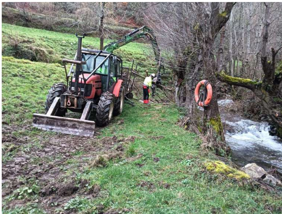
Operarios trabajando en el río Cereixedo
