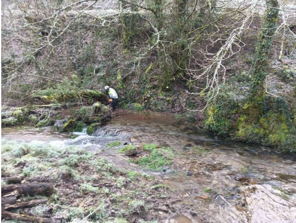
Operario retirando restos vegetales del cauce
