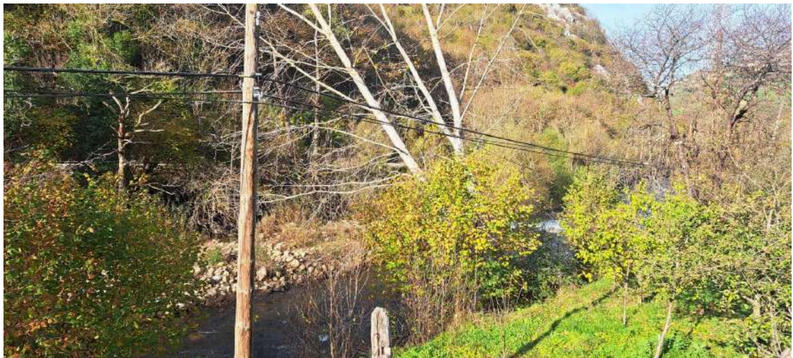
Antes de los trabajos
