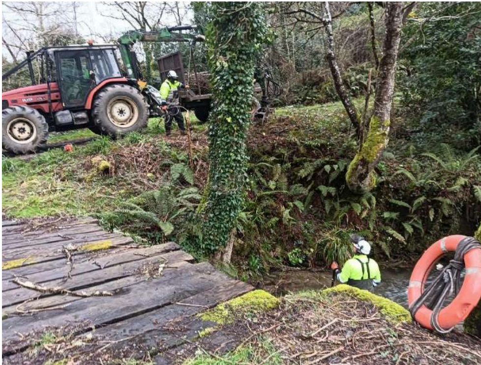
Autocargador y operarios retirando restos vegetales del cauce
