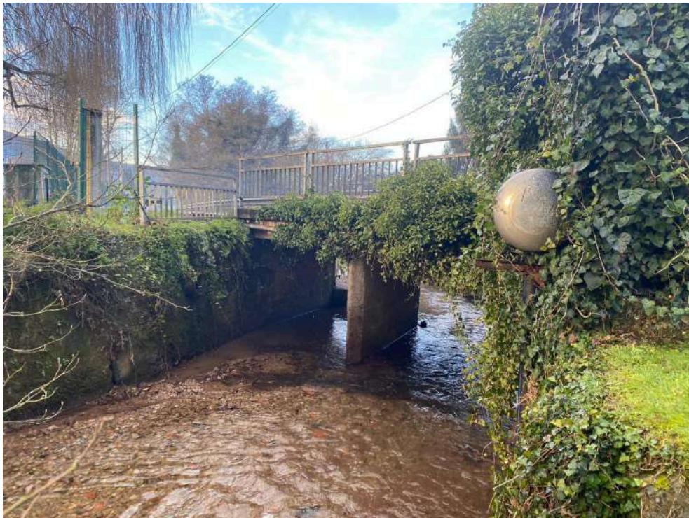
Después de los trabajos
