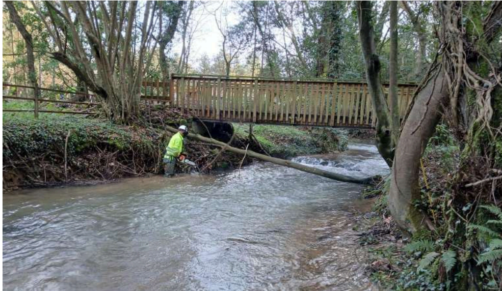
Operario retirando árbol caído perpendicularmente al cauce
