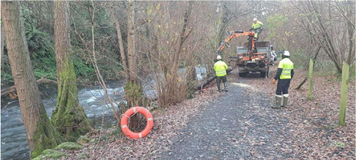
Durante los trabajos. Operarios retirando restos vegetales
