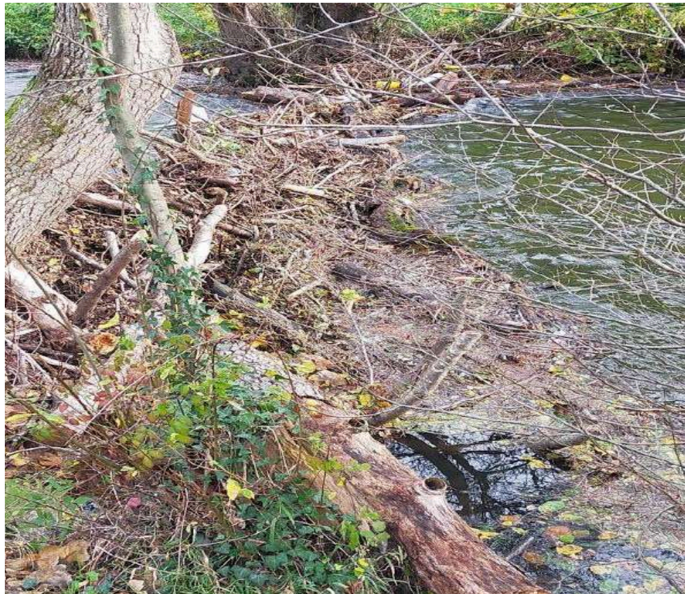
Antes de los trabajos
