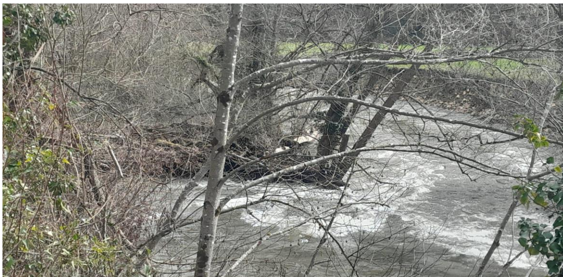
Antes de los trabajos
