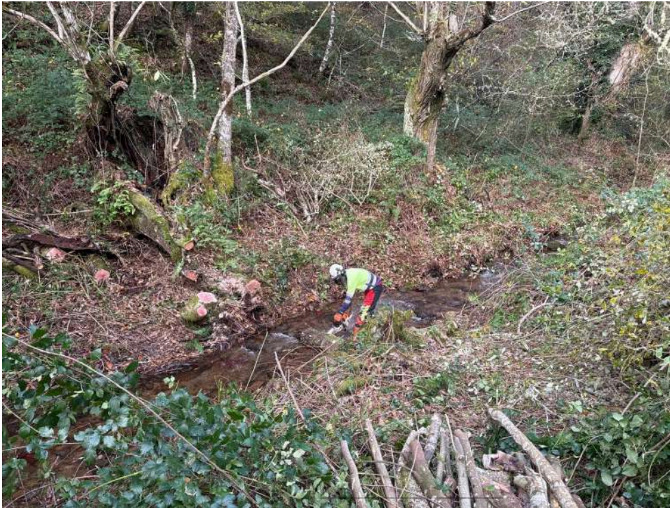
Operarios retirando restos vegetales
