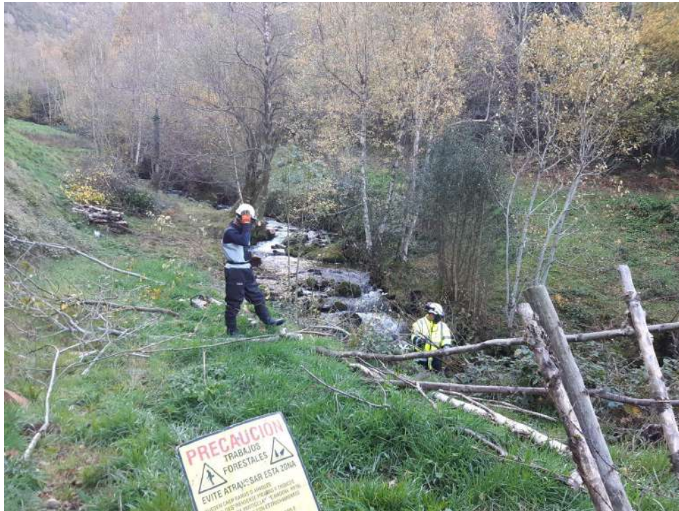
Operarios retirando restos vegetales
