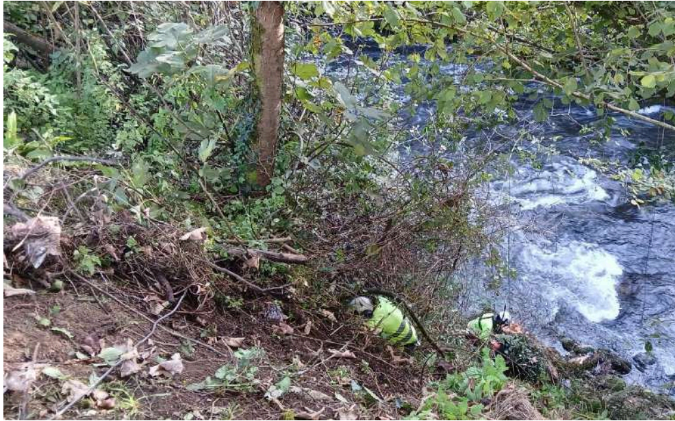
Durante los trabajos. Operarios retirando restos vegetales
