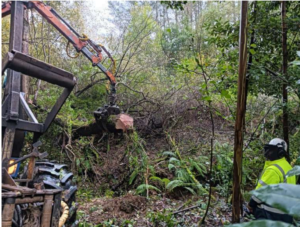
Durante los trabajos
