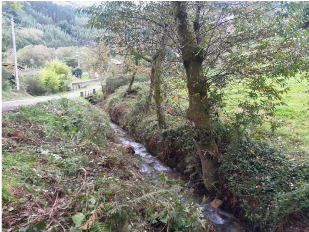
Después de los trabajos
