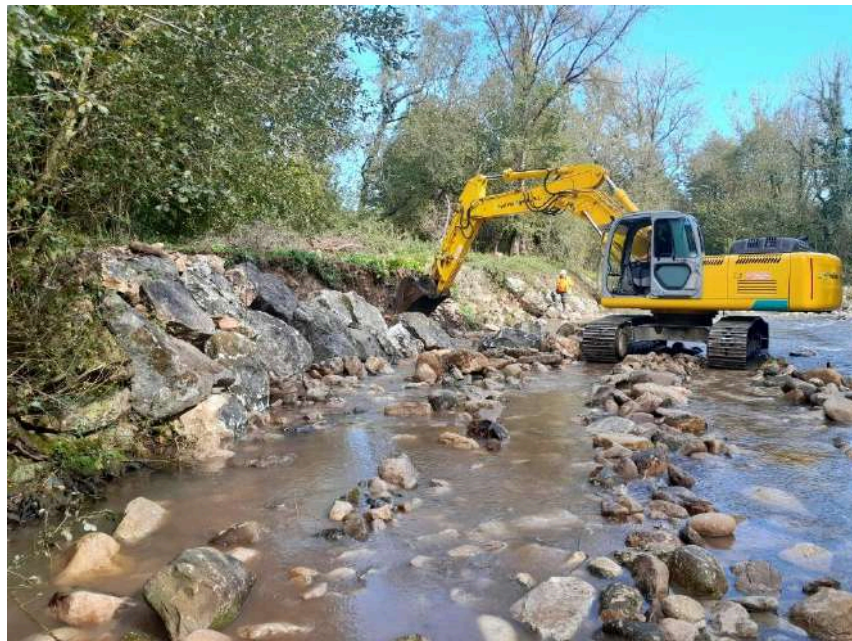
Trabajos de reconstrucción de la escollera
