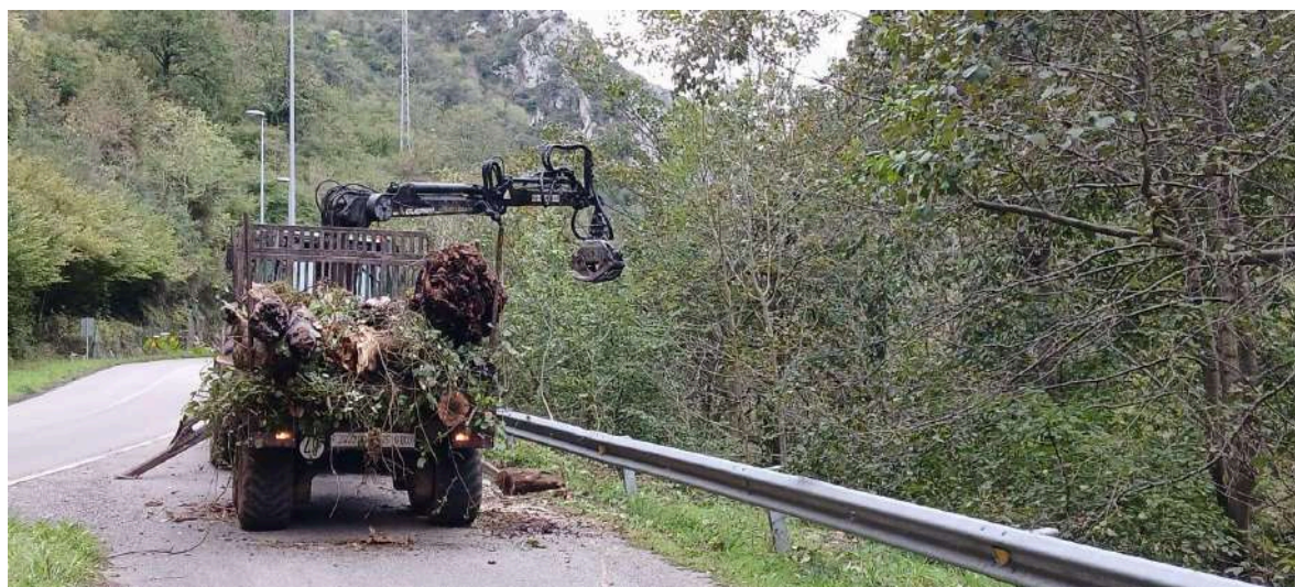
Autocargador retirando restos vegetales
