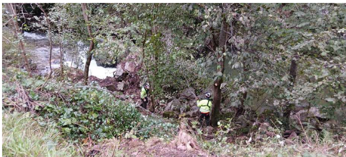
Operarios retirando restos vegetales
