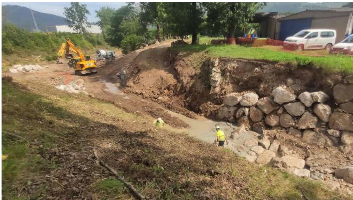
Durante los trabajos en la desembocadura del arroyo Tejas
