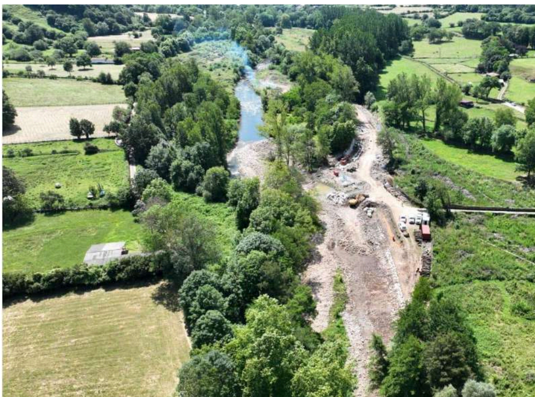
Vista aérea de las obras en Molledo
