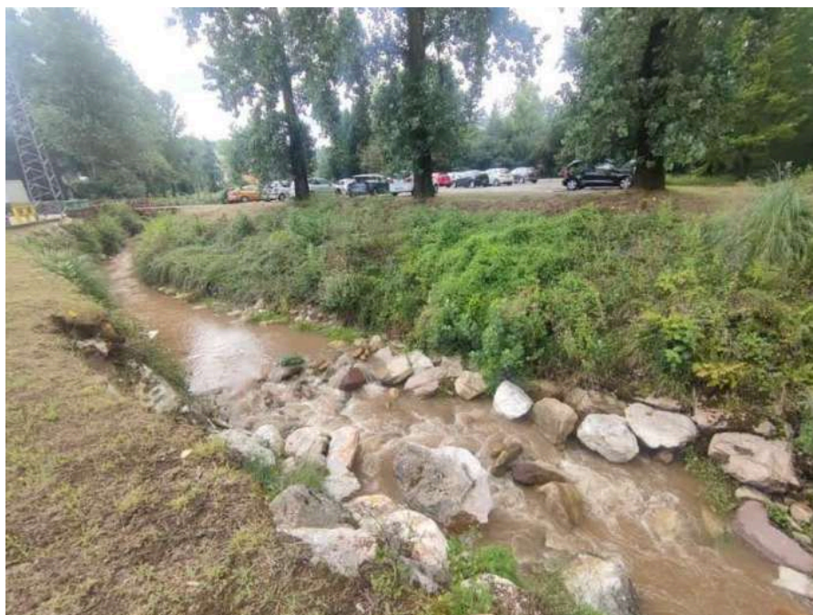
Arroyo Tejas antes de las actuaciones
