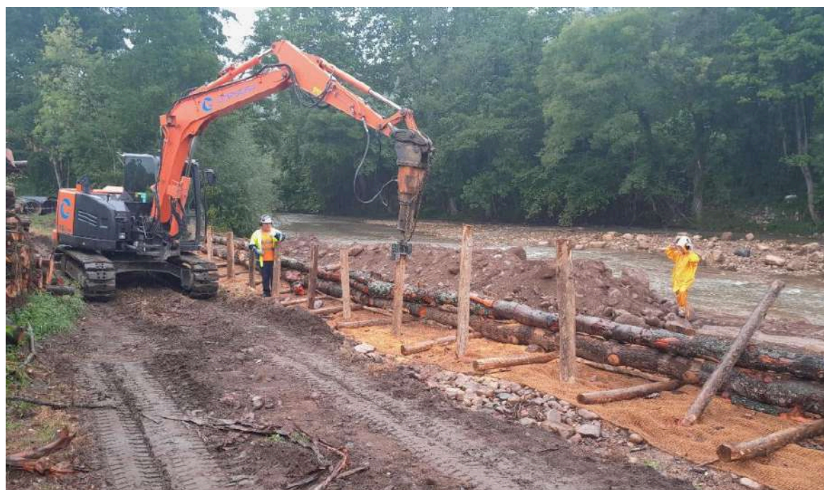
Durante la ejecución de la empalizada
