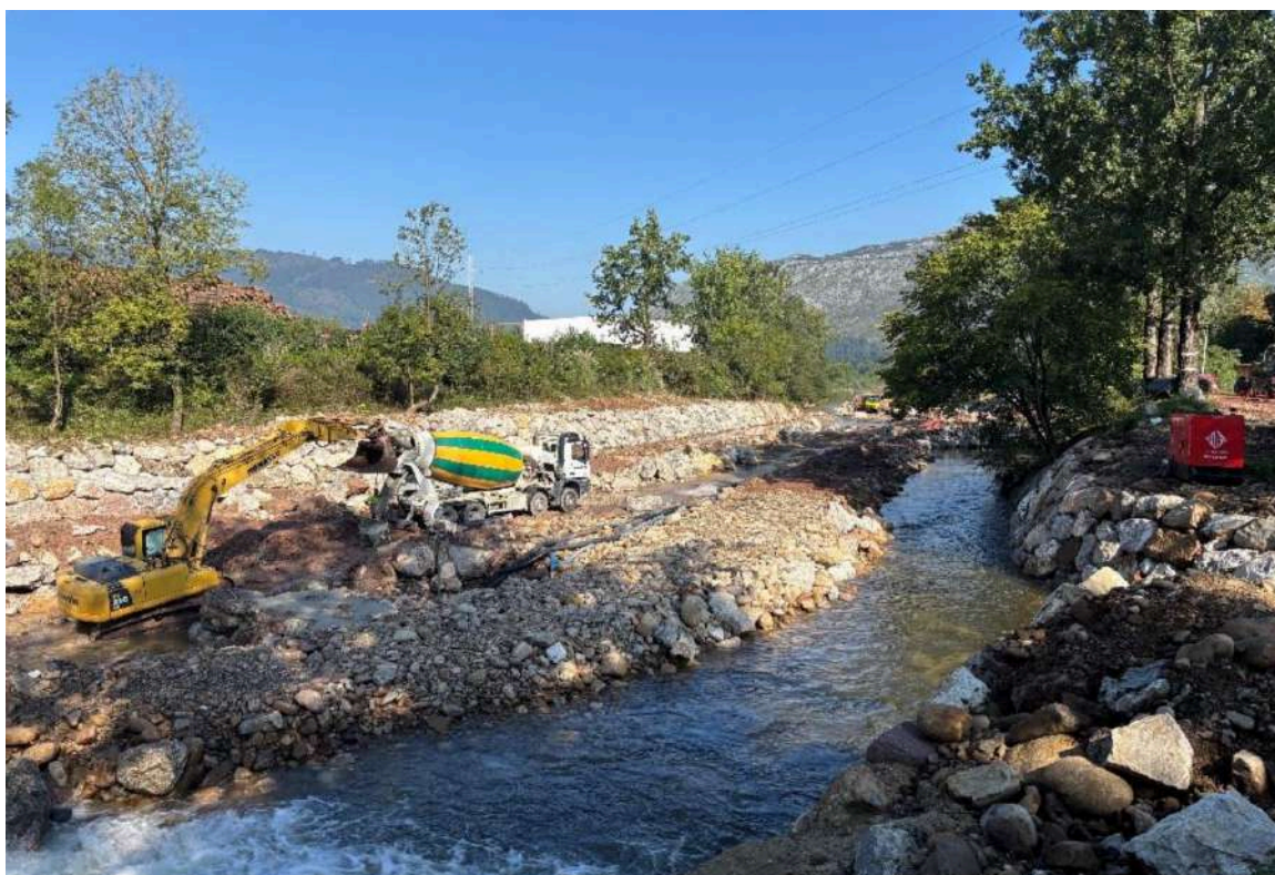
Vista general de las obras aguas abajo
