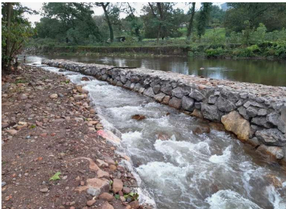
Rampa de peces una vez encauzado el río Besaya por el trazado original
