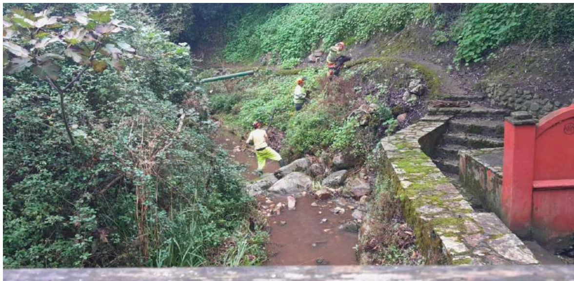
Durante de los trabajos
