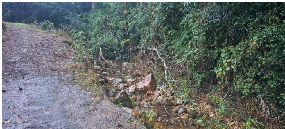
Antes de los trabajos
