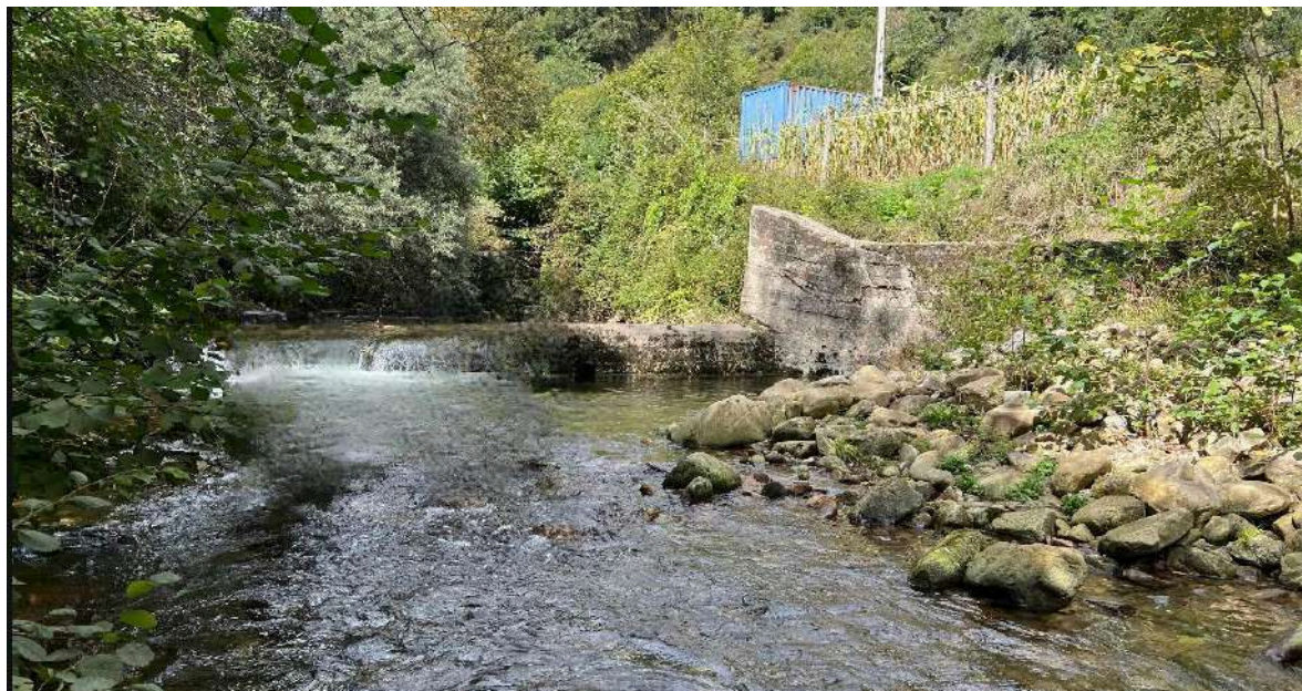
Azud del molino de Sellaño antes de la demolición
