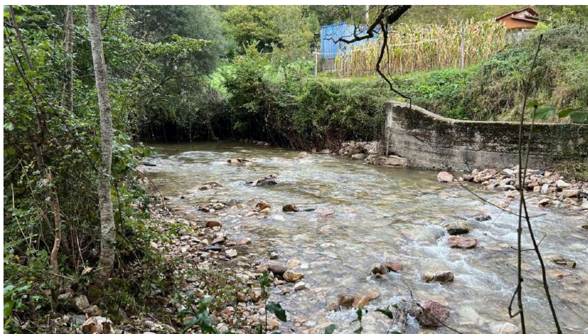
Azud del molino de Sellaño después de la demolición
