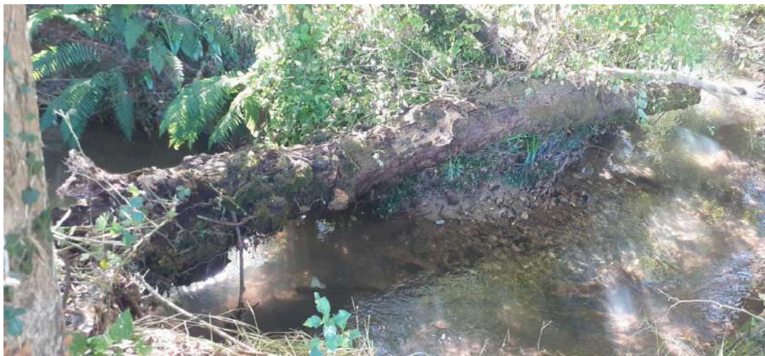
Antes de los trabajos
