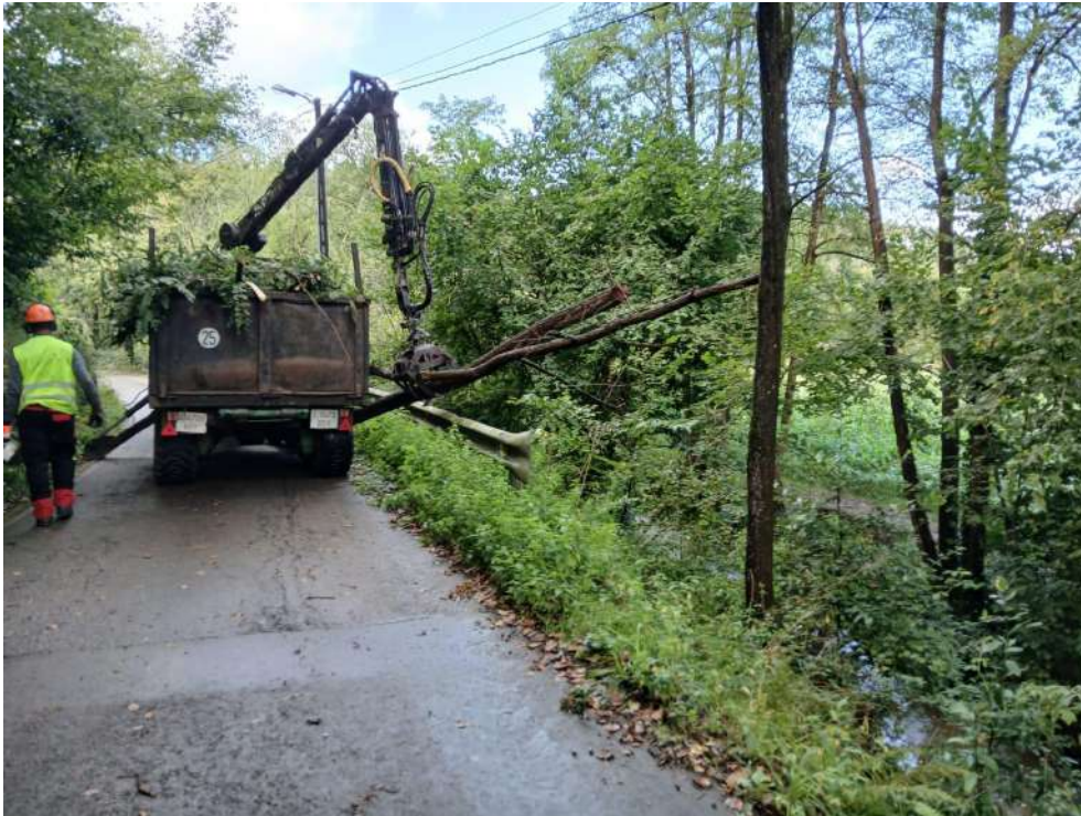
Durante los trabajos
