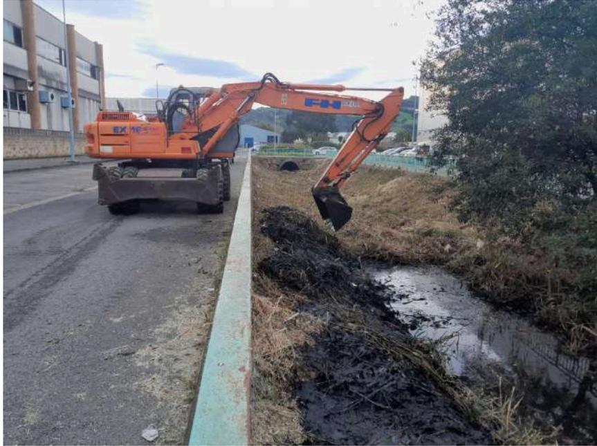
Retirada de restos vegetales y lodos del cauce con retroexcavadora
