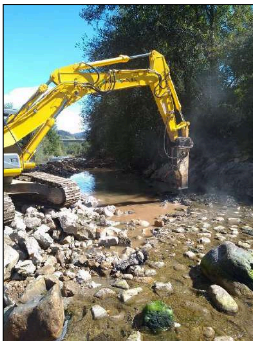
Durante los trabajos de demolición previa a la mejora de la infraestructura
