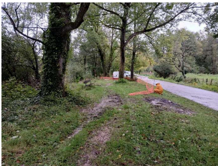
Trabajos de preparación y señalización de los accesos a la obra
