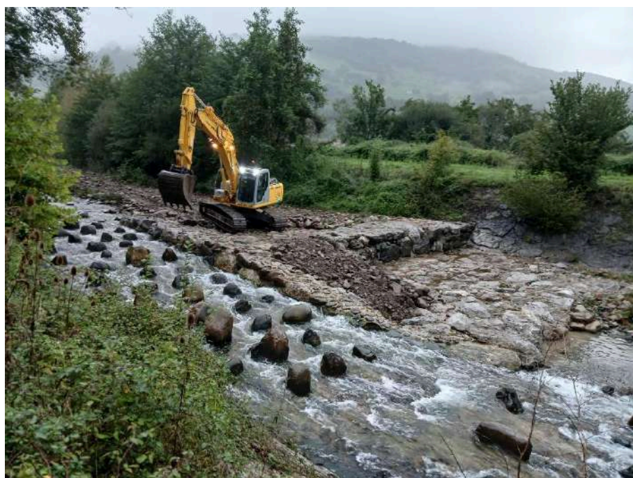
Durante los trabajos preparatorios de acceso y desvío del cauce
