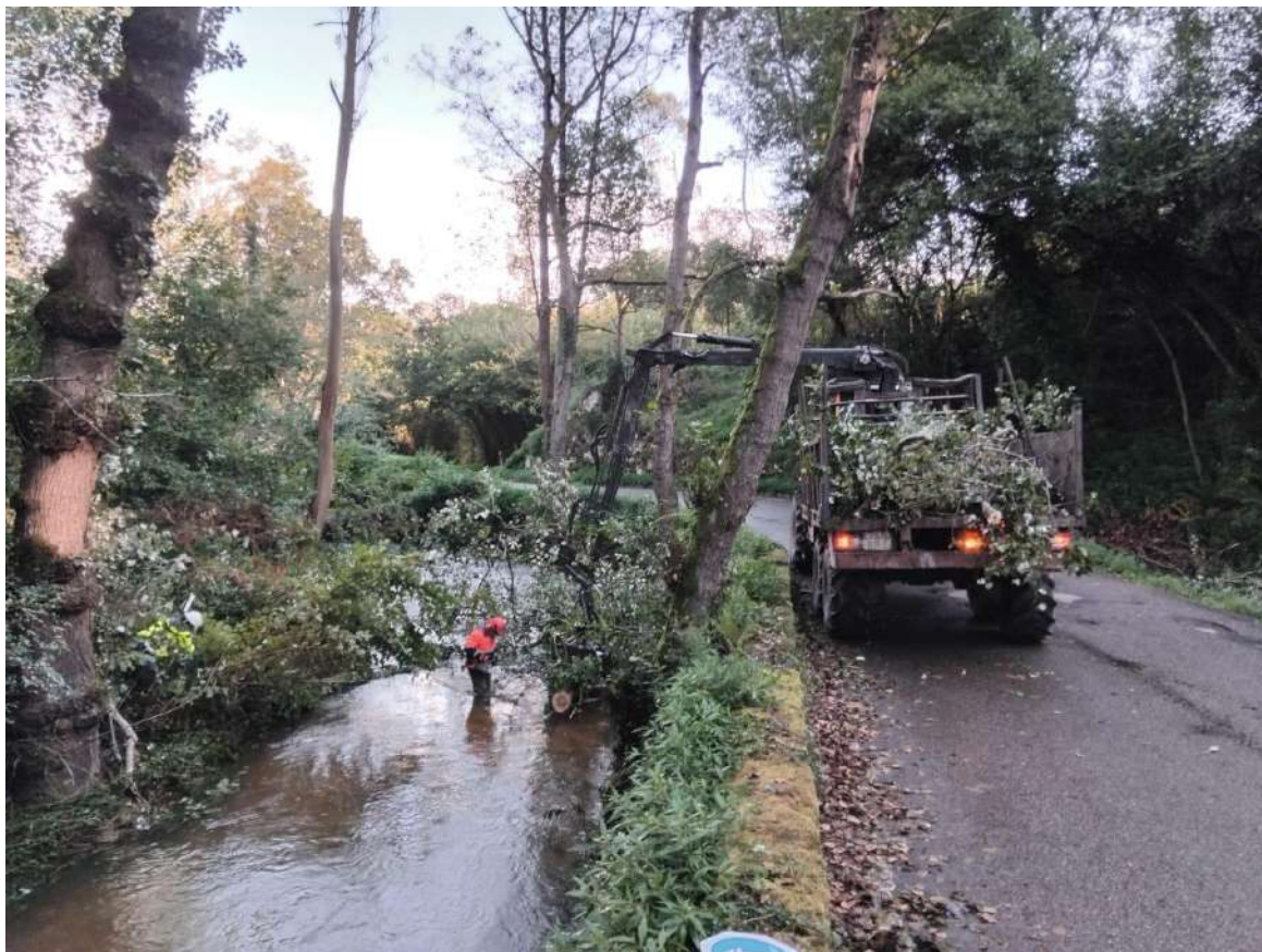
Durante los trabajos en el Ereba
