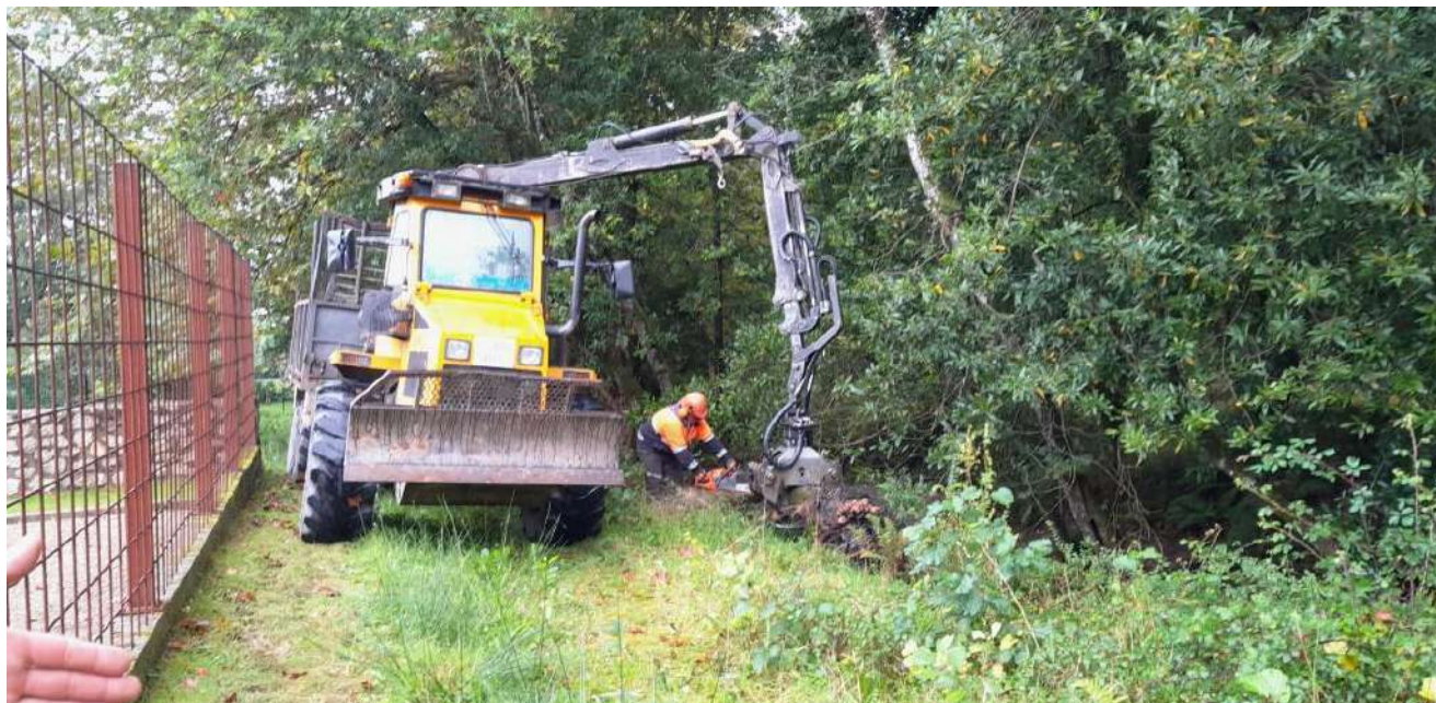
Durante los trabajos en el Mascadoria
