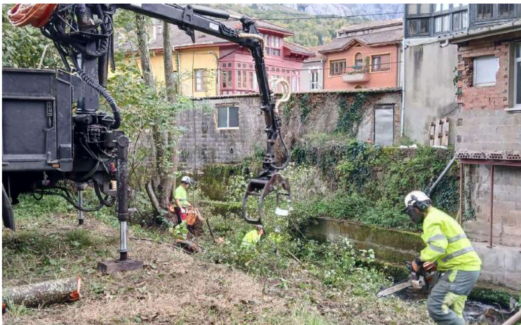
Operarios realizando labores de conservación
