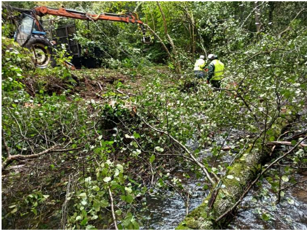
Operarios y autocargador retirando restos vegetales
