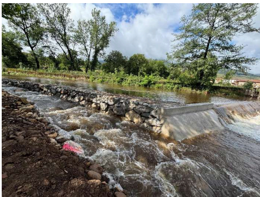
Azud y dispositivo de paso (rampa de piedras) una vez recuperado el cauce original del río Besaya
