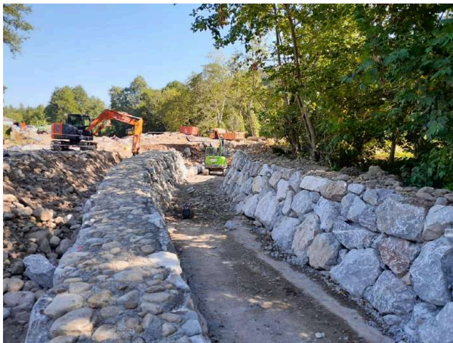
Durante los trabajos de construcción del paso piscícola
