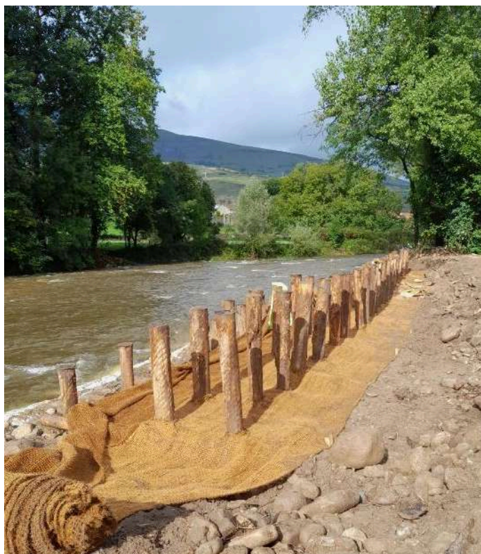
Trabajos de bioingeniería, aguas arriba del azud, para recuperar el cauce original del río Besaya
