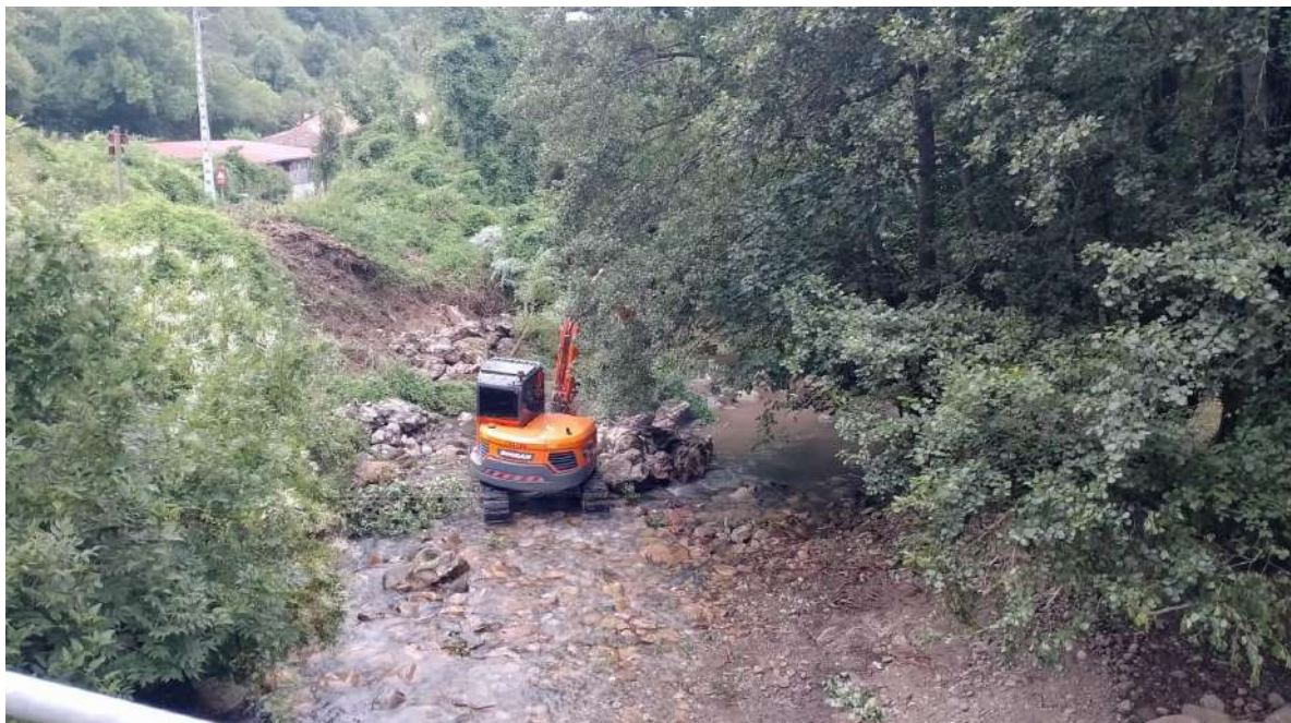
Mini retro demoliendo el azud
