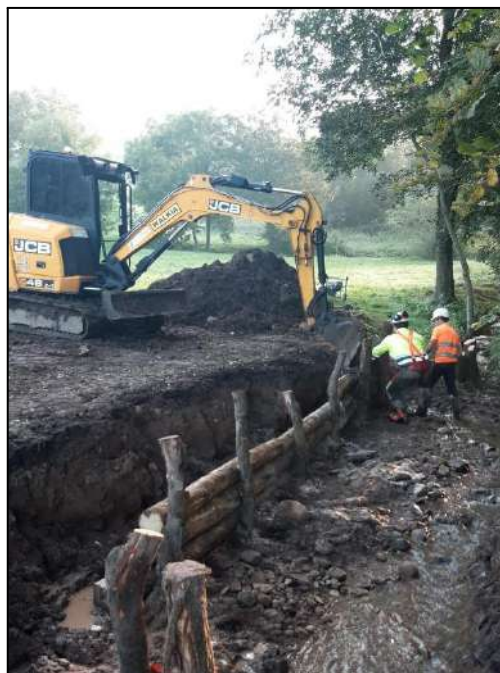
Trabajos de bioingeniería, ejecución de empalizada para la estabilización de la margen derecha
