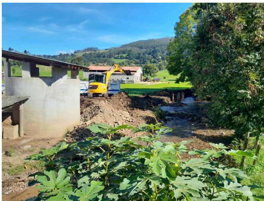
Trabajos de estabilización del talud de la margen derecha
