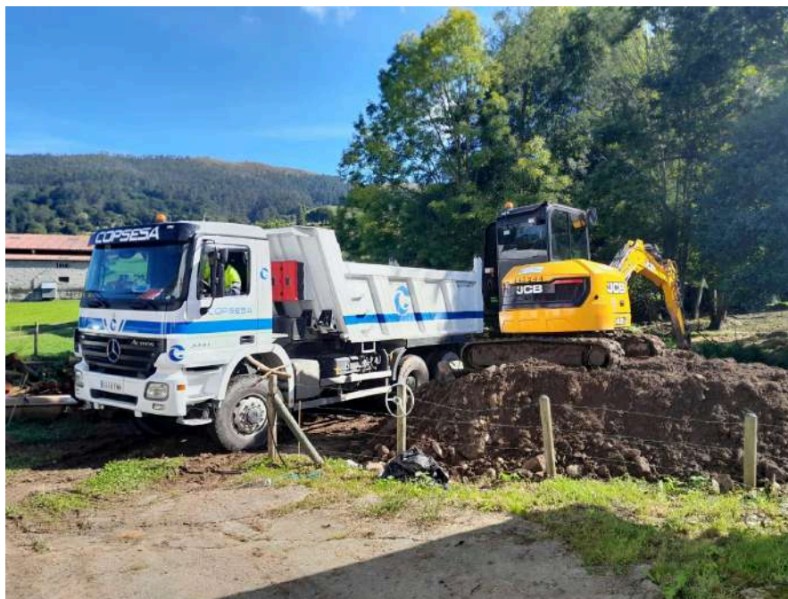
Trabajos de retirada de los acarreos acumulados
