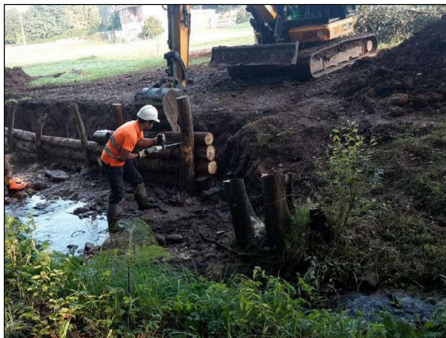
Durante la ejecución de empalizada en la margen derecha
