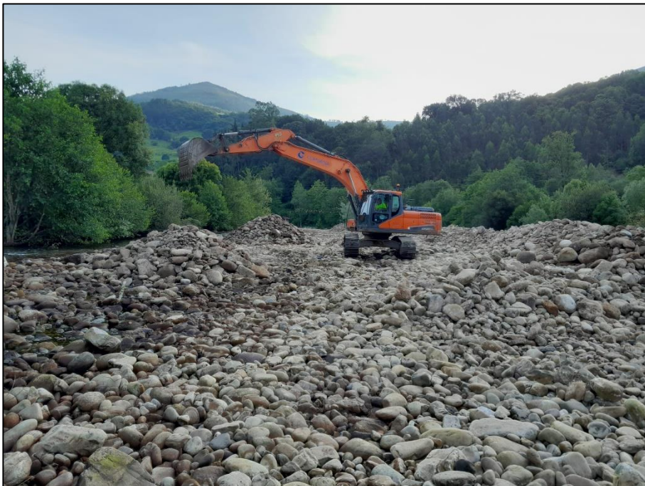
Trabajos de reapilado de los acarreo
