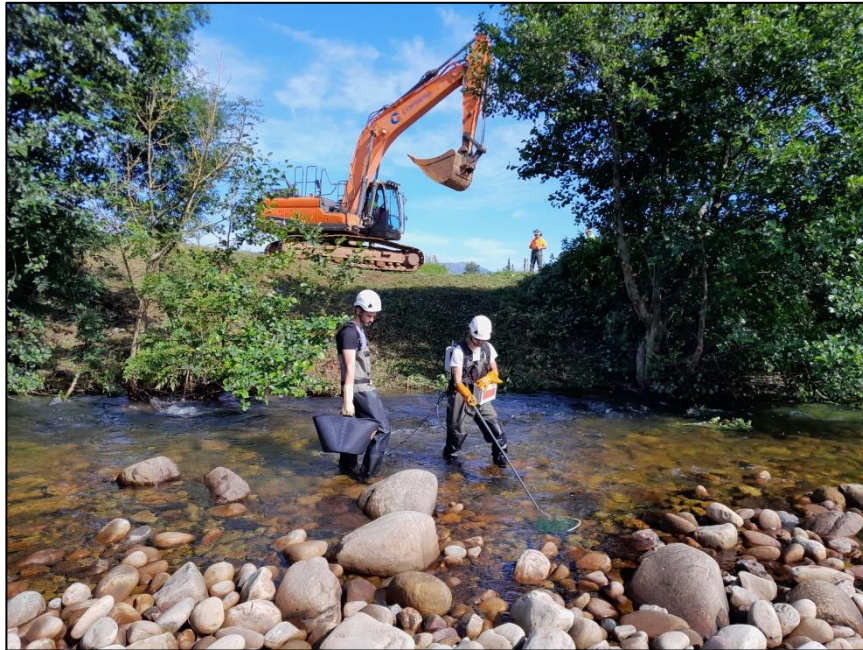
Trabajos previos de pesca eléctrica para el rescate de la fauna piscícola
