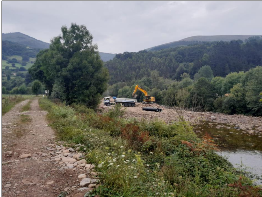
Trabajos mecánicos de retirada de la acumulación de acarreo
