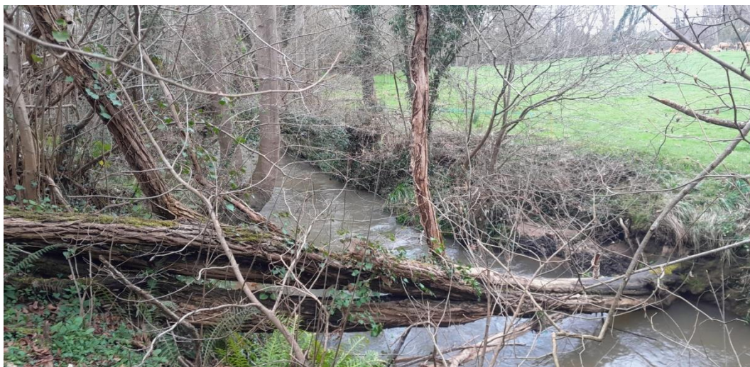
Antes de los trabajos
