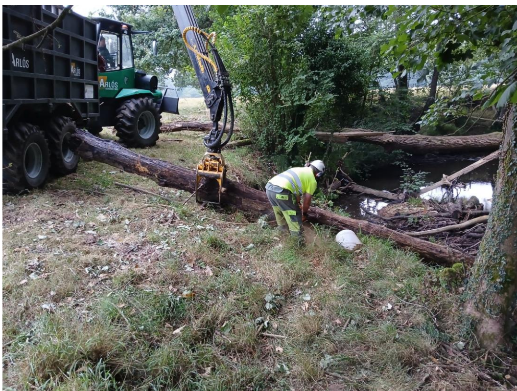
Operario y autocargador retirando restos vegetales
