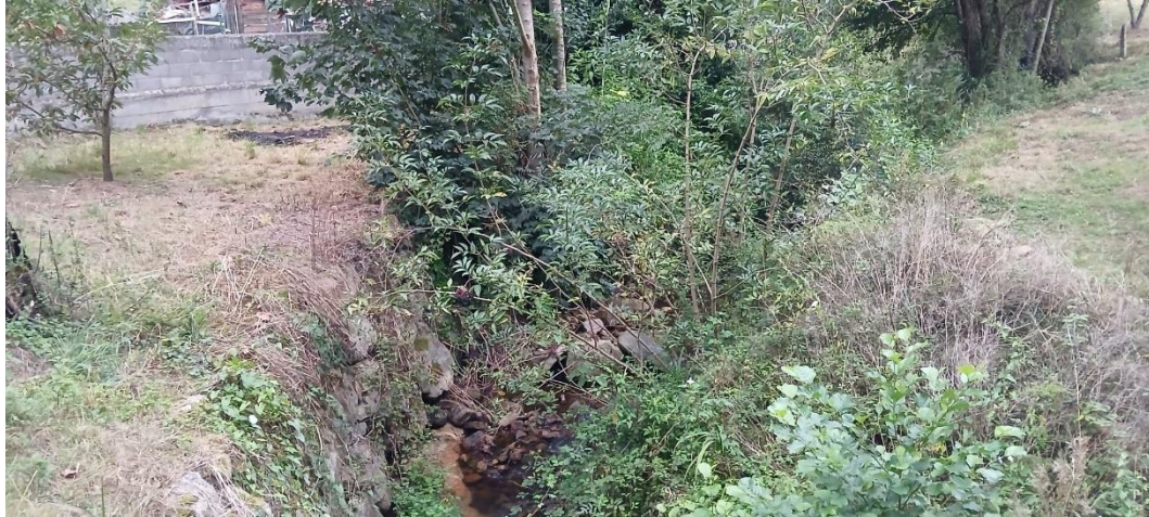
Antes de los trabajos
