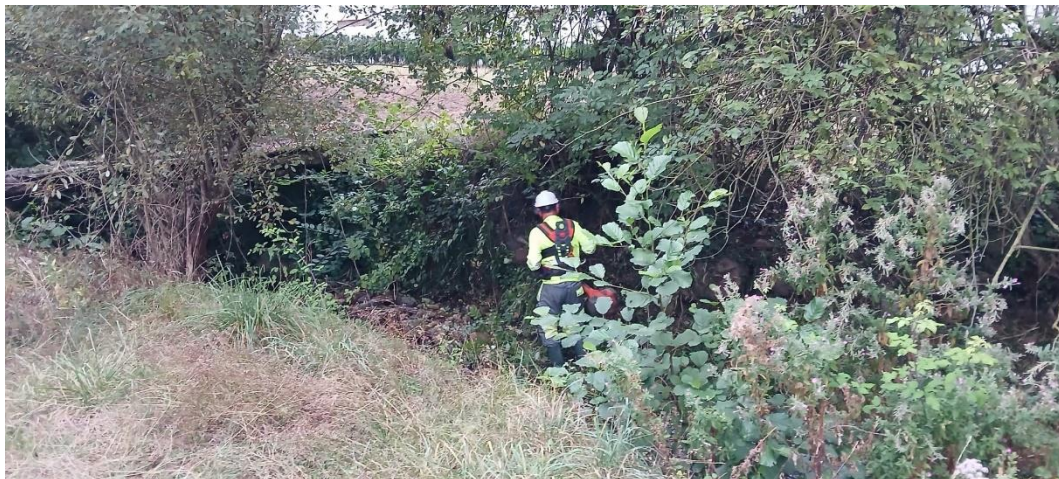
Operario desbrozando dentro del cauce
