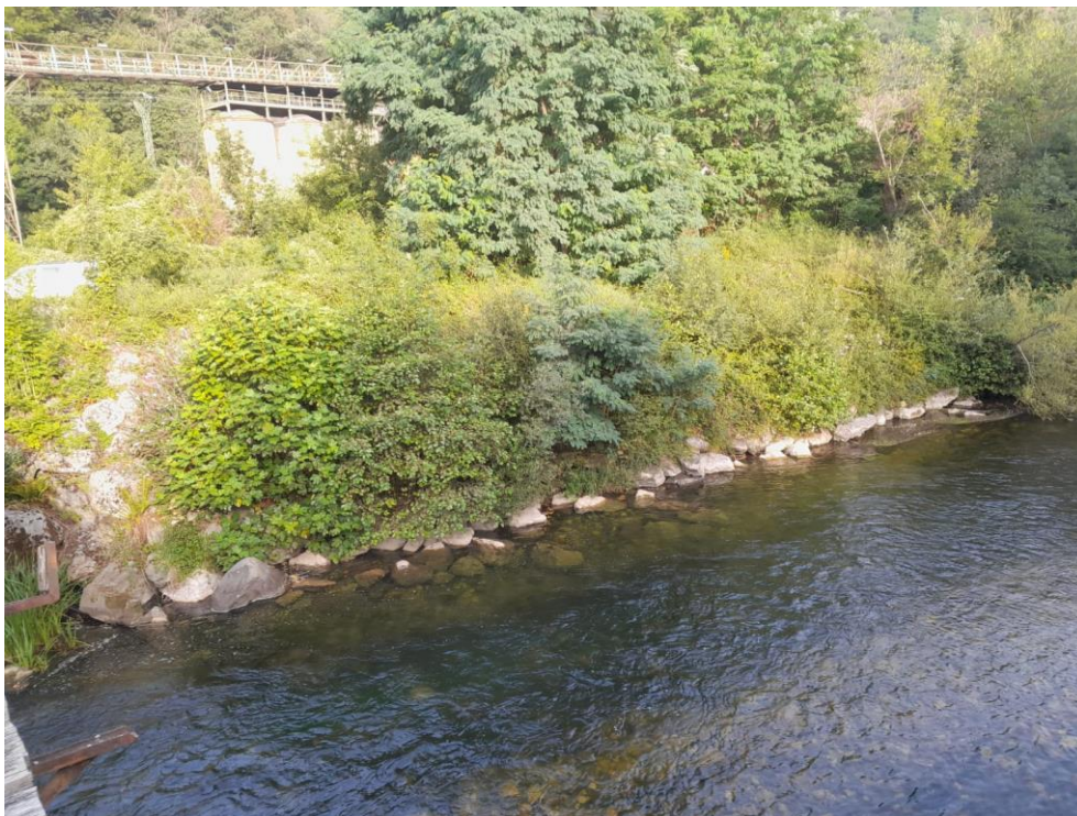
Antes de los trabajos
