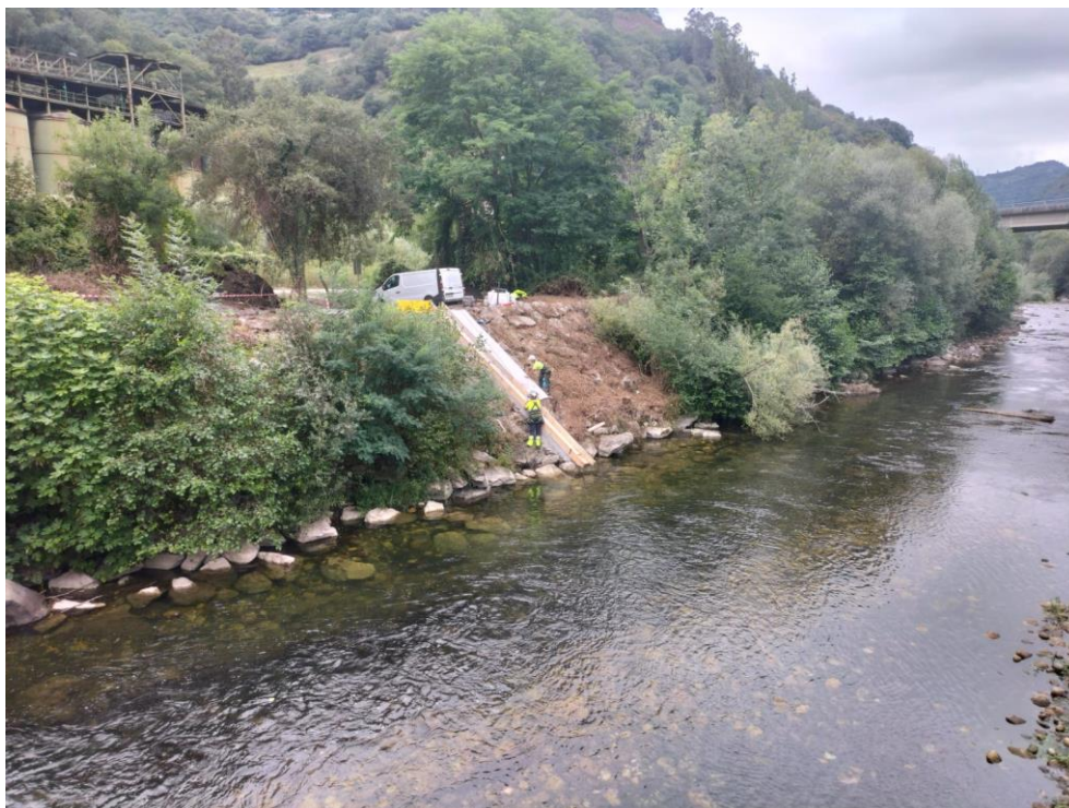
Operarios trabajando en la obra civil
